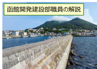
② 北海道における港湾修築の 先駆的な構造物である石積防波堤
